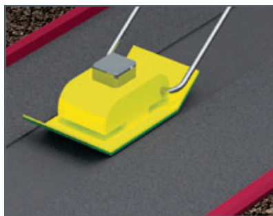
7. Влаштування монтажного шару з відсіву (фракція 0-5) товщиною 50 мм і його ущільнення трамбуванням.
