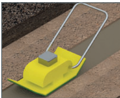
2. Влаштування корита і ущільнення його основи трамбуванням.
