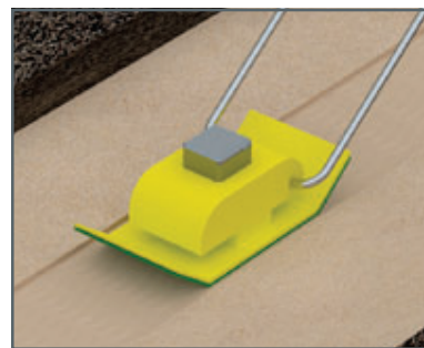
3. Влаштування піщаної основи (пісок річковий) і його ущільнення трамбуванням.
