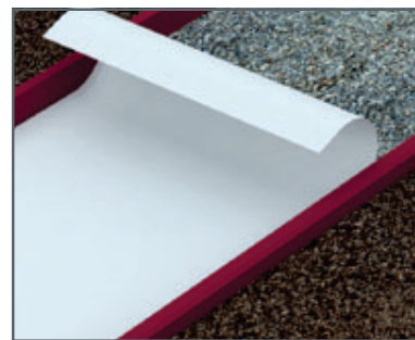
6. Укладання голкопробивного геотекстилю (щільність 120г / м2).
