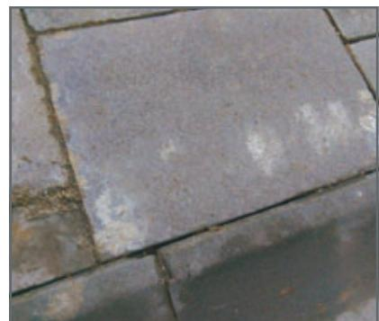
Ні в якому разі не допускати попадання глини (в тому числі і в складі ярового піску) на лицьову поверхню тротуарної плитки — плитка змінить колір.
