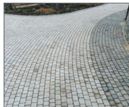
Ні в якому разі не допускати, щоб робітники різали болгаркою бетонну плитку на уже вкладеній тротуарній плитці — бетонний пил має частки цементу, який при попаданні на лицьову поверхню призведе до втрати коліору назавжди.
