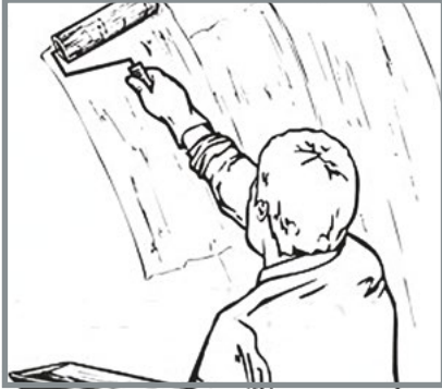
Підготовка стіни до укладання облицювального каменю.
