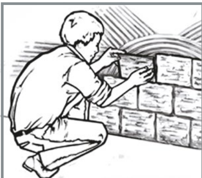
Укладання облицювального каменю на стіну
