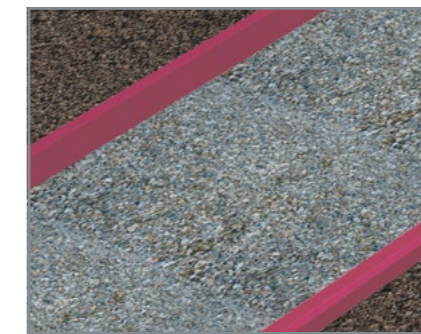
5. Установка поребриків в бетонний замок на ущільнену основу.
