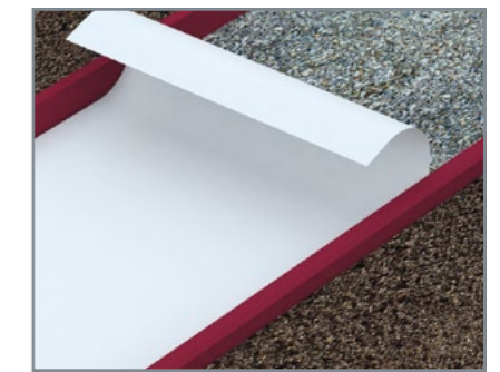
6. Укладання голкопробивного геотекстилю (щільність 120г / м2).
