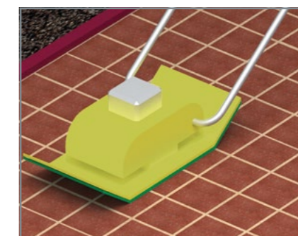
10. Трамбовка тротуарної плитки.
