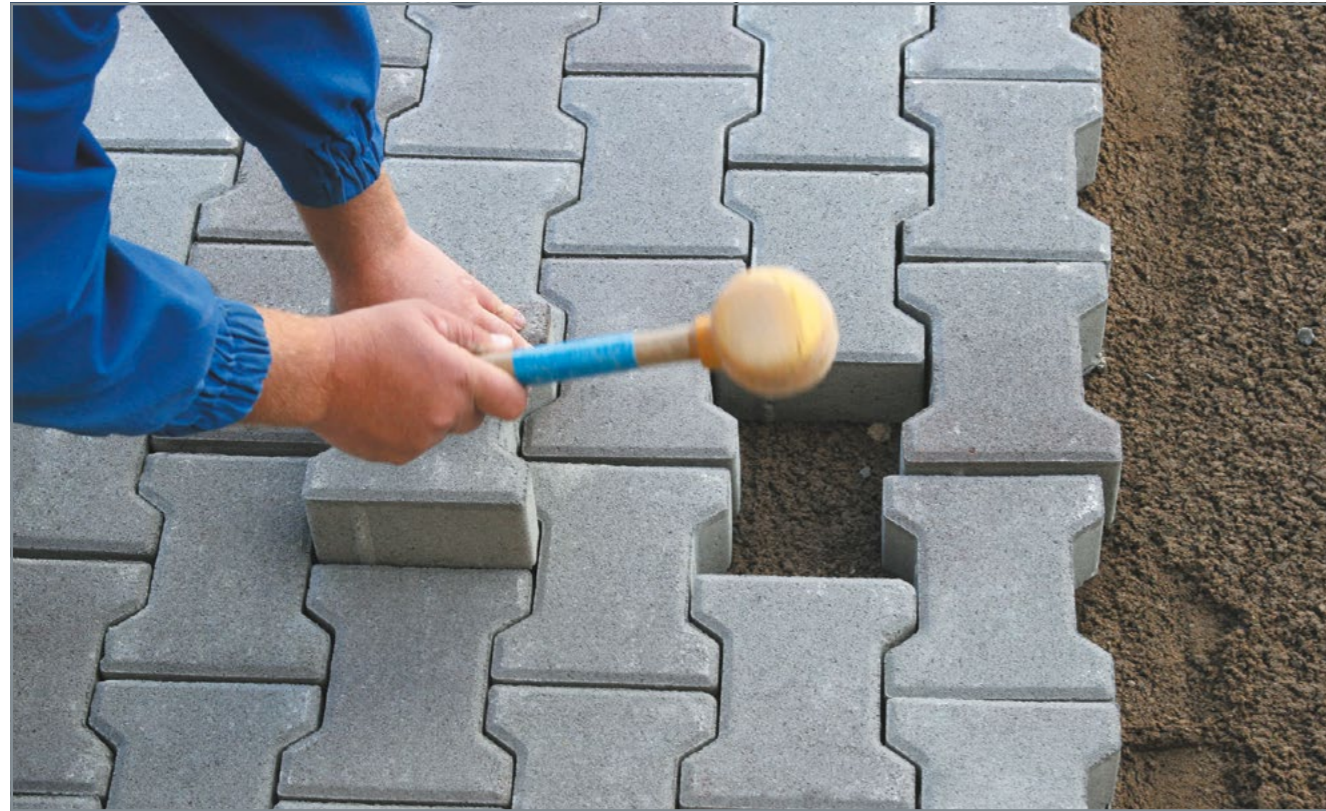
Вибір тротуарної плитки
