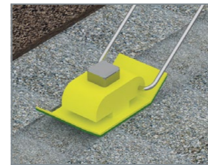
4. Влаштування щебеневої основи згідно проекту і його ущільнення трамбуванням.
