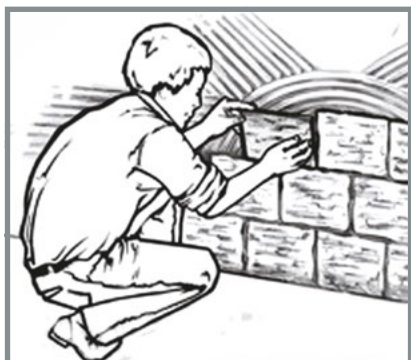
Укладання облицювального каменю на стіну
