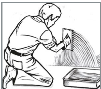
Нанесення клейової мастики на стіну
