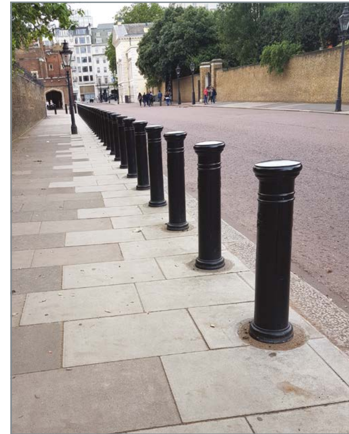
Боллард. Металл. Забетонирован в тротуар на 30см. Защищает тротуар от наезда транспорта. Выполнен в строгом стиле. Широкоформатные тротуарные плиты без фаски с тонкими швами для удобства передвижения. Бетон.
