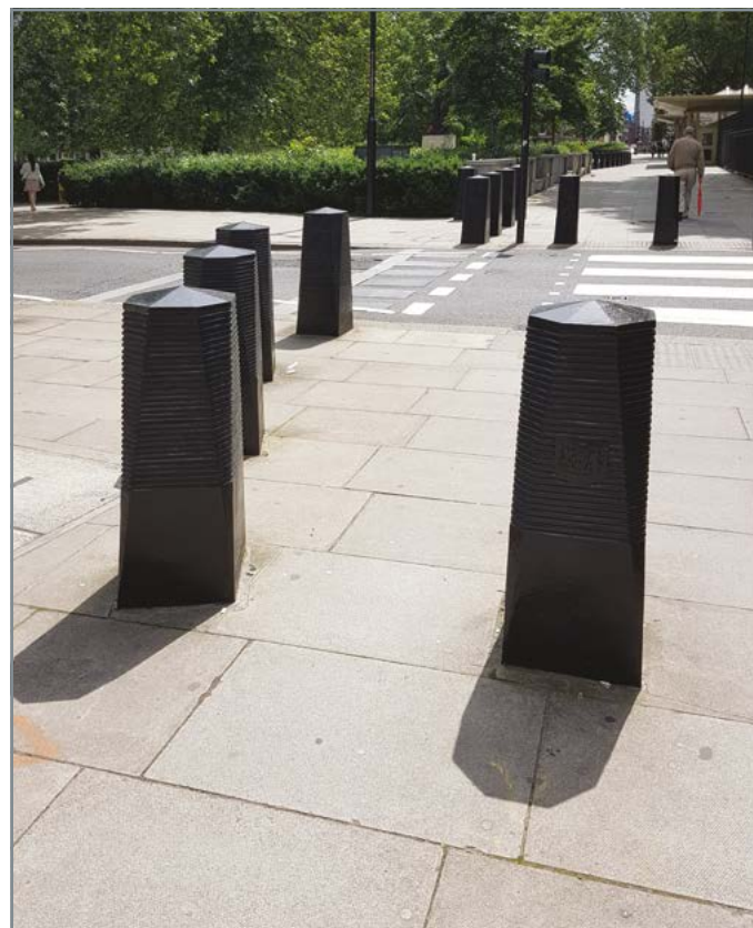
Боллард. Чугун. Забетонирован в тротуар на 30см. Ограничение подъезда к забору посольства США. Дизайн классический. Широкоформатные тротуарные плиты без фаски для удобства передвижения. Бетон.
