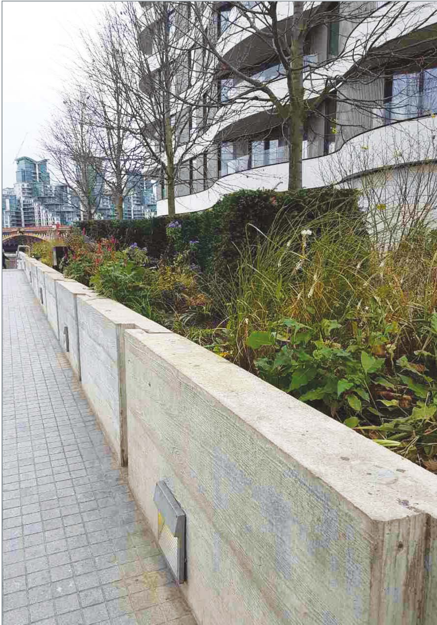
Приподнятая клумба. Озеленение и ограждение придомовой территории. Бетонная стена с подсветкой.
