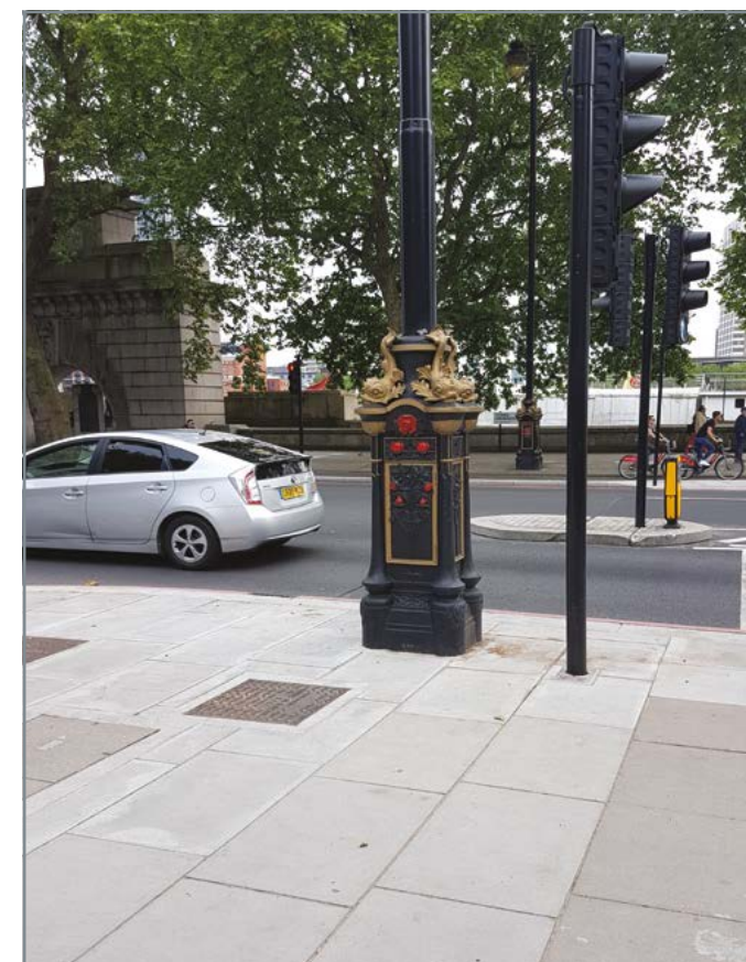
Широкоформатные тротуарные плиты без фаски с тонкими швами для удобства передвижения. Бетон. Фонарь. Чугунное основание с объемным декором. Дизайн классический.
