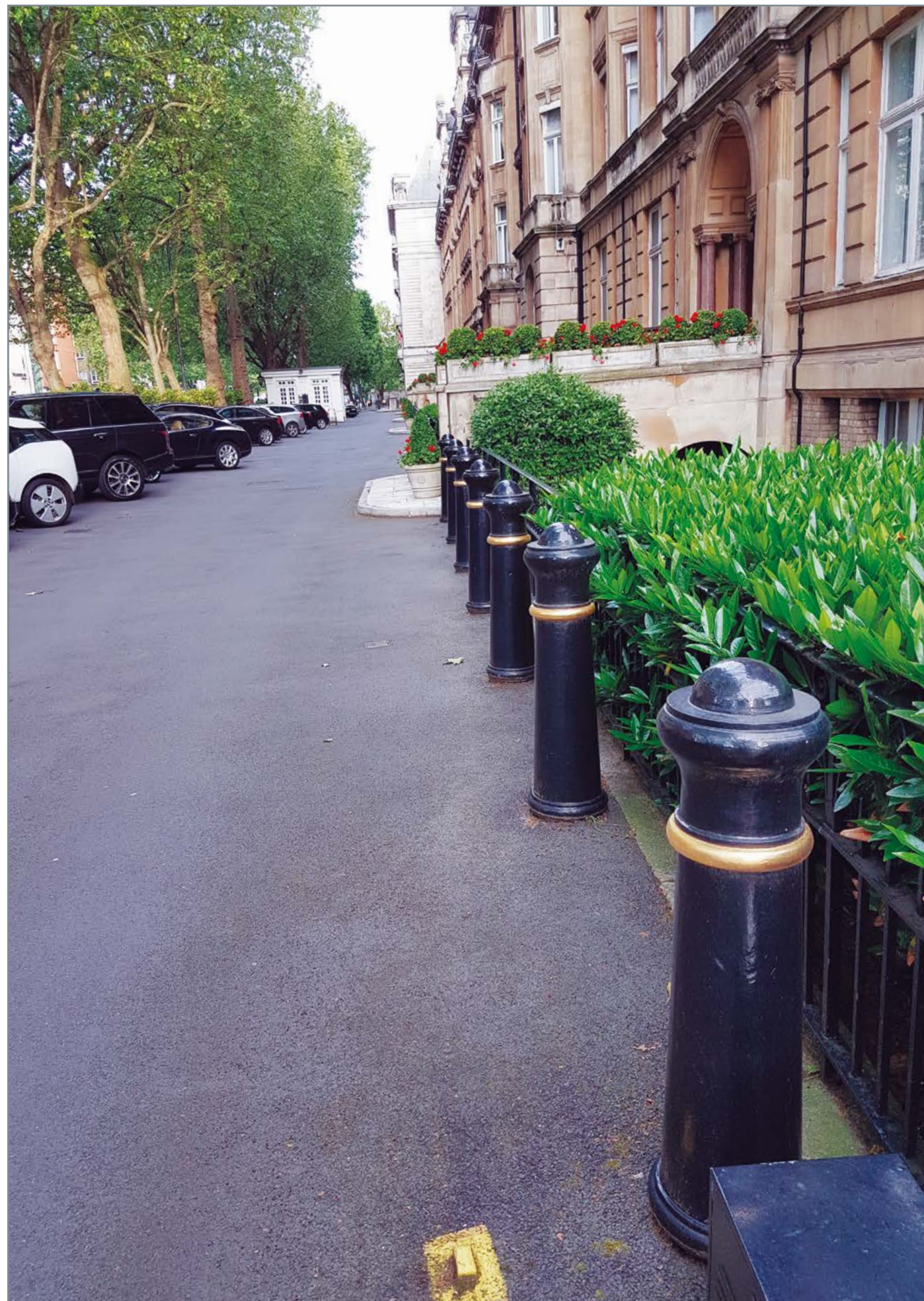
Боллард. Металл. Забетонирован в тротуар на 30см. Отделяет парковку от придомовой территории.
