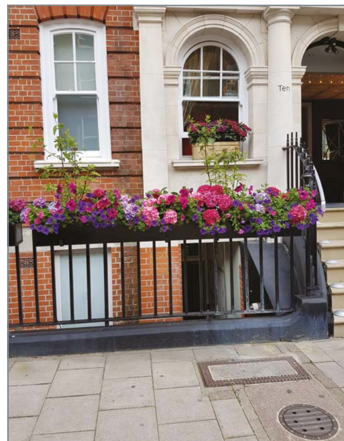
Цветочница. Озеленение фасада. Решетка. Окрашенный металл. Защита окон первого этажа от проникновения. Широкоформатные тротуарные плиты с тонкими швами для удобства передвижения. Бетон.
