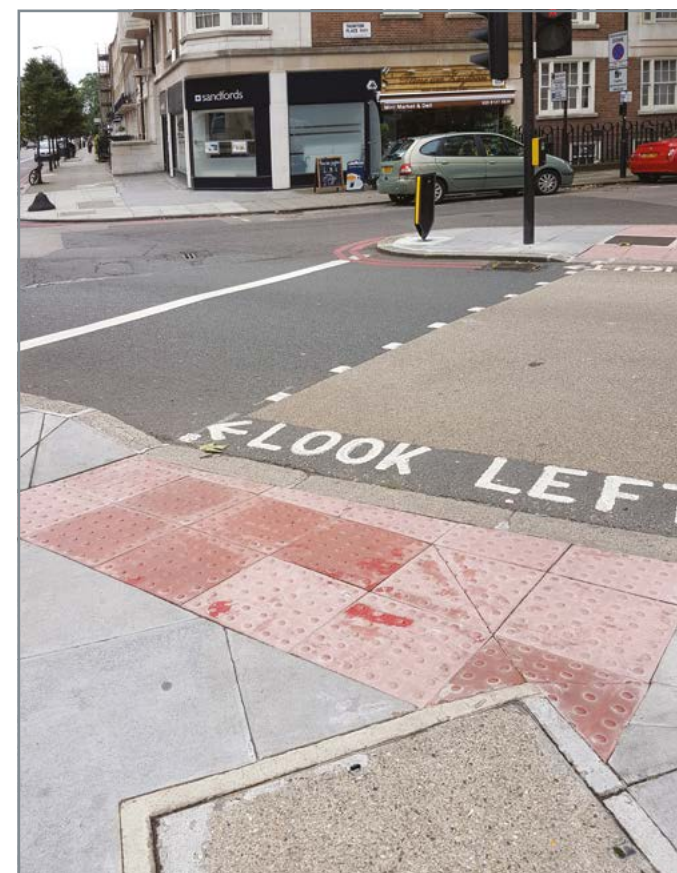
Плавный съезд на переходе. Специальная плитка для слепых с пупырышками. Типичные для Лондона указатели для пешеходов (куда смотреть, так как движение левостороннее). Боллард в форме колокола на повороте для защиты тротуара.
