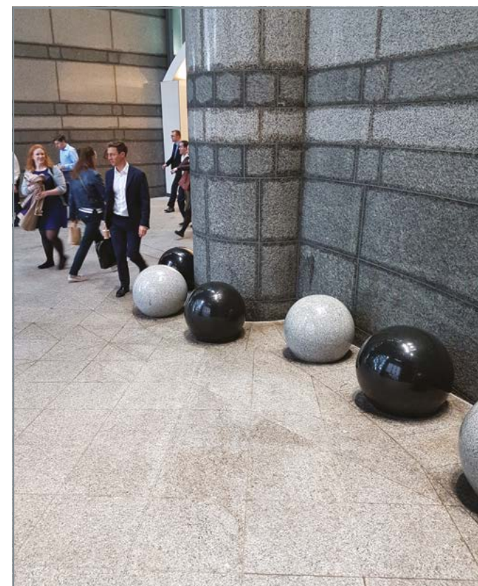
Боллард. Натуральный камень. Установлен на тротуар. Защищает фасад от повреждений. Служит для кратковременного отдыха пешеходов.
