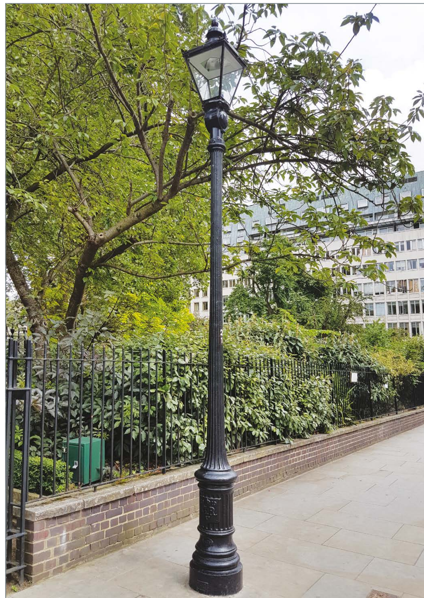
Фонарь. Окрашенный металл. Освещает улицу. Дизайн классический. Широкоформатные тротуарные плиты без фаски с тонкими швами для удобства передвижения. Бетон.
