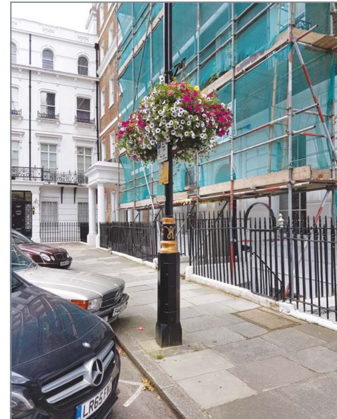
Цветочница на фонарном столбе. Озеленение улицы. Ограда. Окрашенный металл. Широкоформатные тротуарные плиты без фаски с тонкими швами для удобства передвижения. Бетон.
