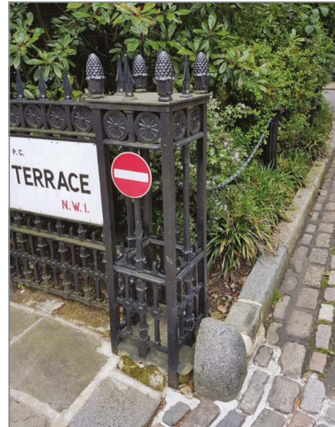
Ограда. Окрашенный металл. Служит опорой для знаков и указателей. Дизайн классический. Бетонный элемент для защиты ограды от наезда транспорта.
