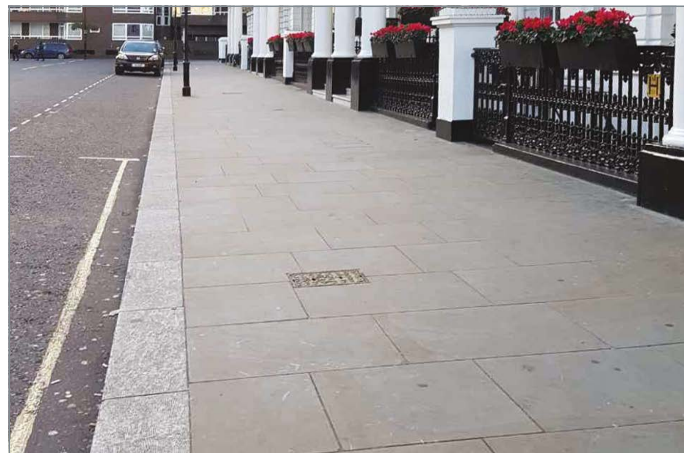
Широкоформатные тротуарные плиты без фаски с тонкими швами для удобства передвижения. Бетон. Широкий дорожный борд. Желтая сигнальная дорожная разметка. Металлическая ограда здания. Цветы.
