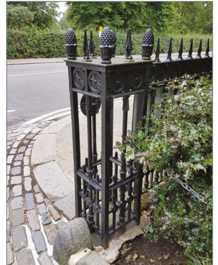
Ограда. Окрашенный металл. Ограждает частную территорию. Дизайн классический. Скругленный дорожный борт. Бетонный элемент для защиты забора от повреждения.
