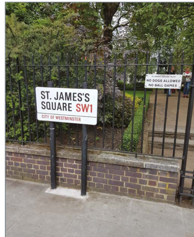
Ограда. Окрашенный металл. Отделяет территорию парка от тротуара. Служит опорой для указателей. Дизайн классический. Широкоформатные тротуарные плиты без фаски с тонкими швами для удобства передвижения. Бетон.
