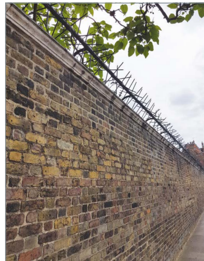
Стена кирпичная с металлической защитой от проникновения.
