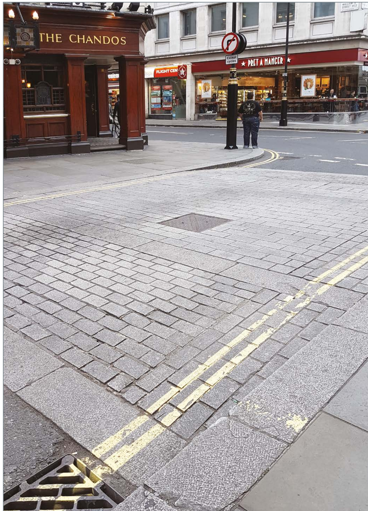
Приподнятый дорожный переход, который выходит на один уровень с тротуаром для удобного переезда на коляске. Одновременно является «лежачим полицейским». Широкий дорожный борд. Желтая сигнальная дорожная разметка. Ливнеприемник, чтобы вода не собиралась перед возвышением.
