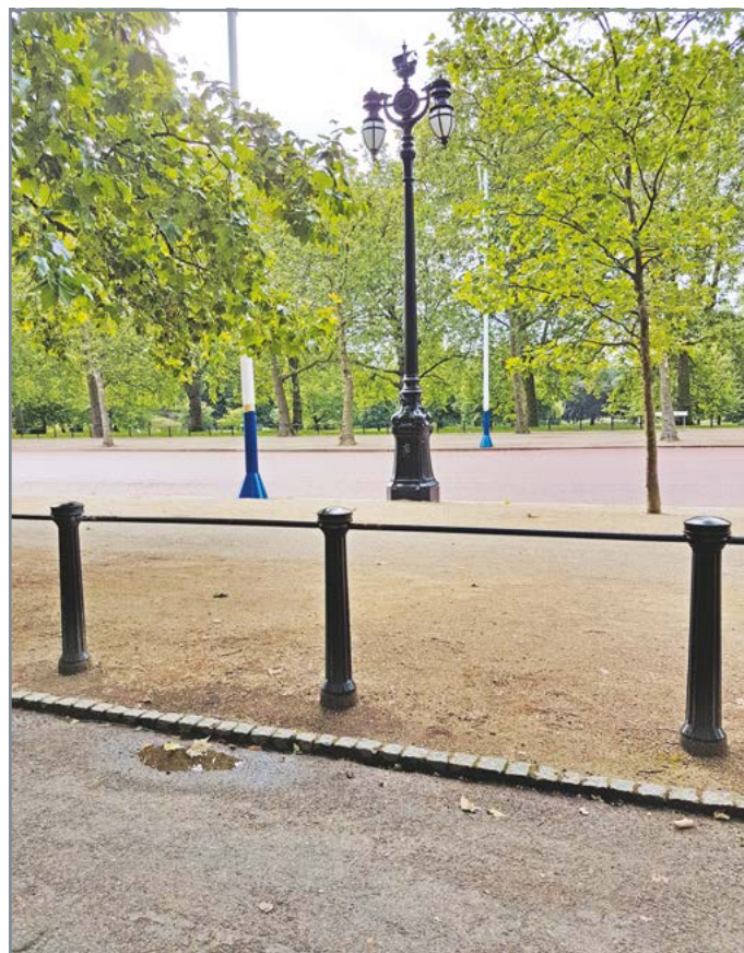
Боллард. Металл. Забетонирован в тротуар на 30см. Защищает прогулочную зону от наезда транспорта. Дизайн классический.
