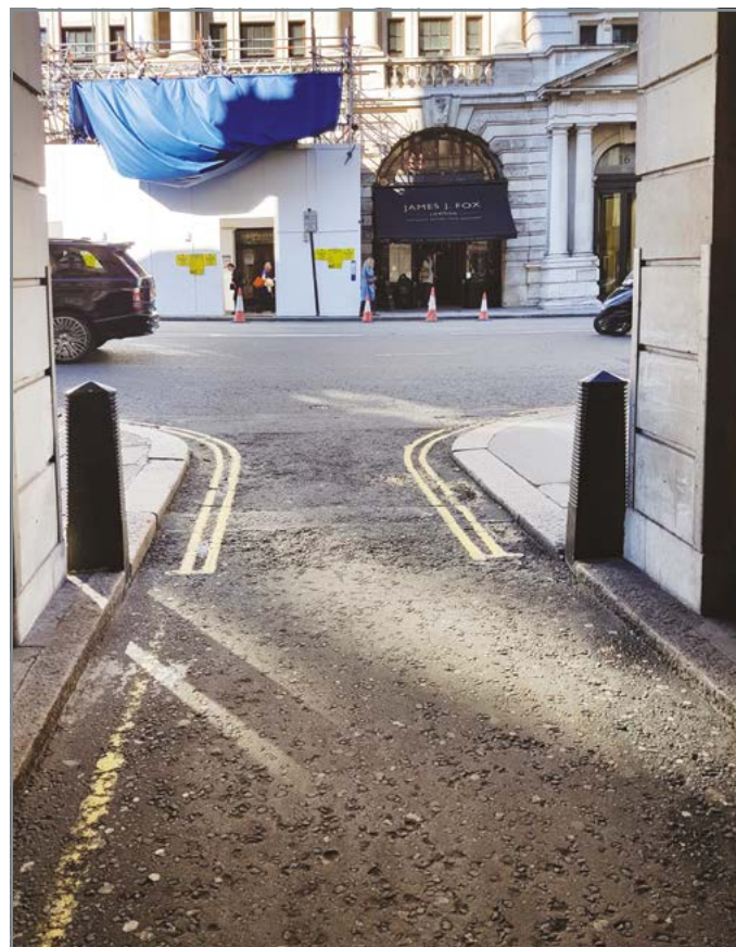
Боллард. Чугун. Забетонирован в тротуар на 30см. Защищают углы дома от повреждений. Ограничивающая и направляющая разметка для транспорта.
