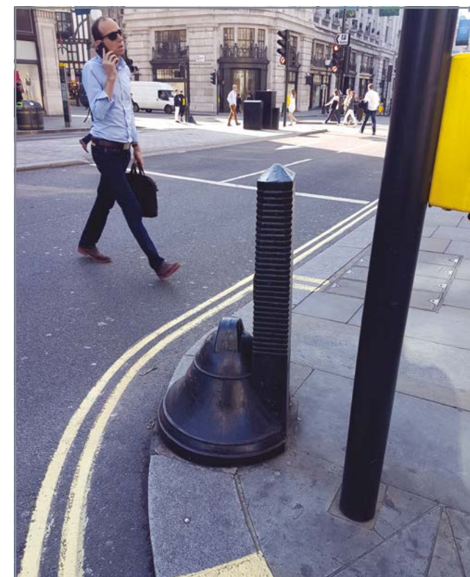
Комбинация двух боллардов. Чугун. Забетонирован в тротуар на 30см. Колокол служит для предотвращения наезда на тротуар задних колес грузовиков при повороте. Скругленный дорожный борд. Сигнальная разметка для транспорта.
