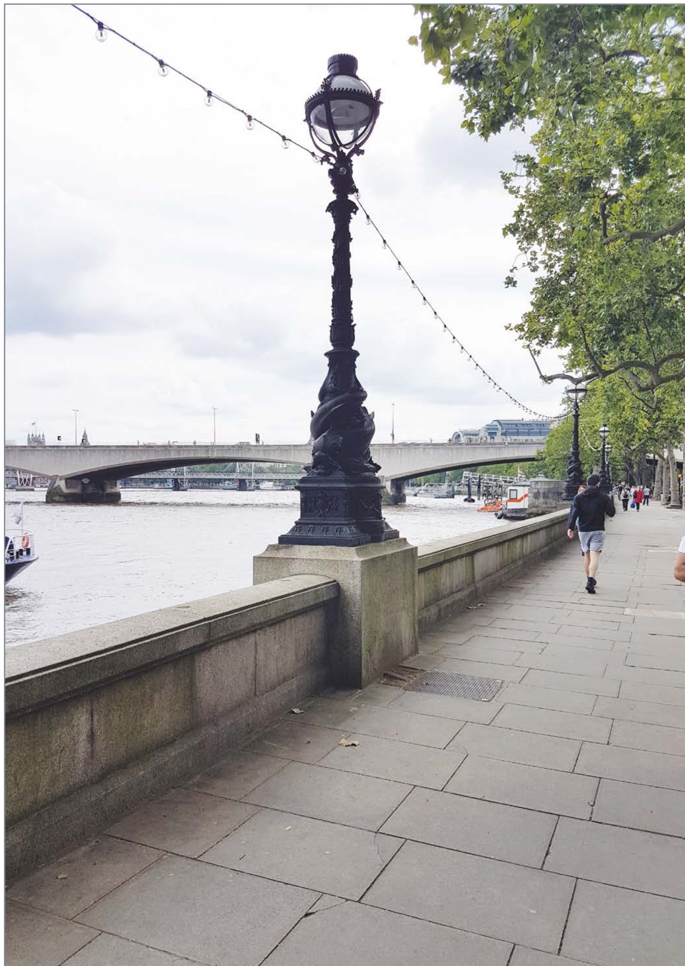
Фонарь. Чугун. Освещает набережную. Дизайн классический. Широкоформатные тротуарные плиты без фазки с тонкими швами для удобства передвижения. Бетон.
