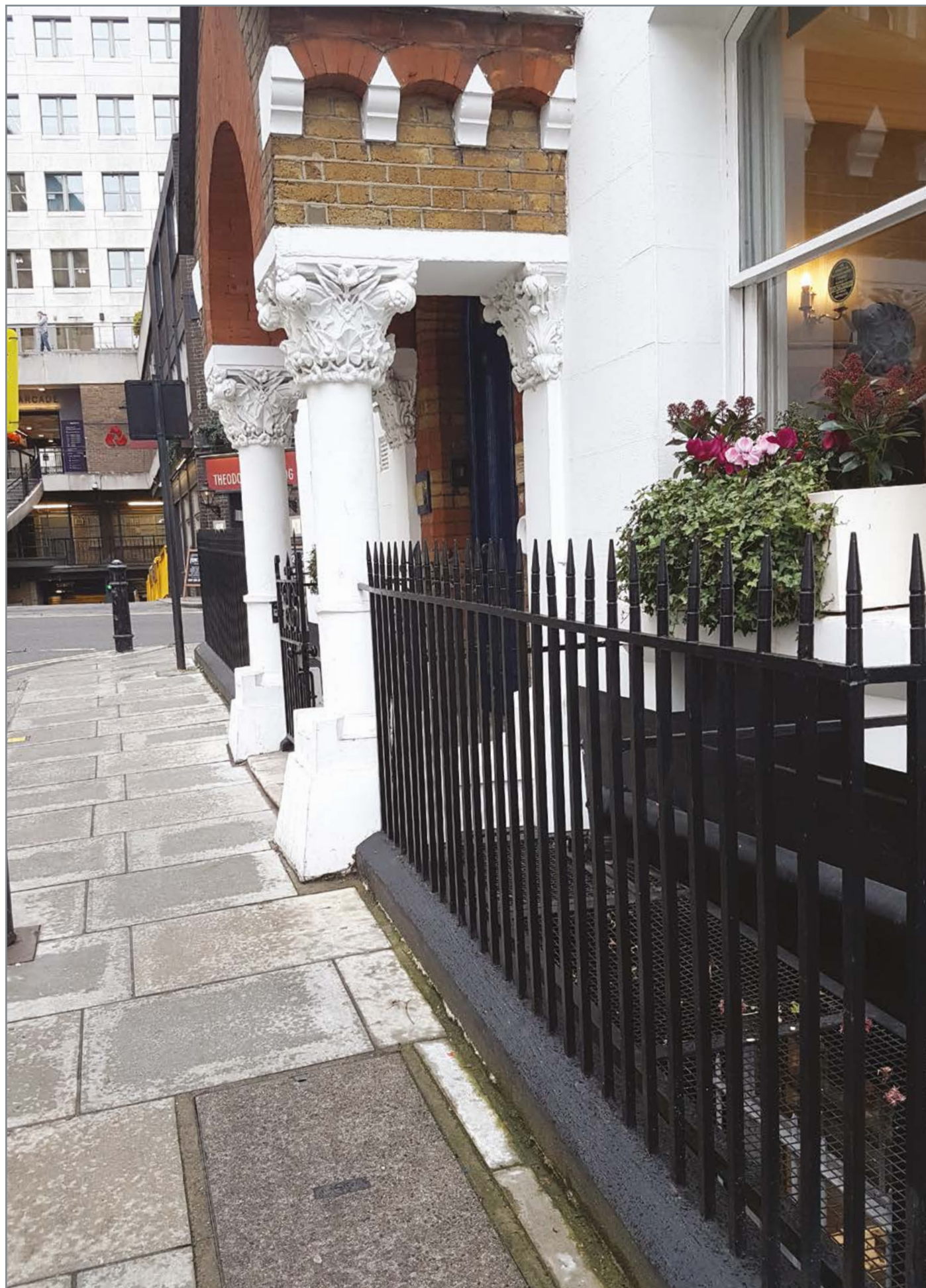
Ограда. Окрашенный металл. Отделяет тротуар от придомовой территории. Защищает окна первого этажа от проникновения. Дизайн классический. Широкоформатные тротуарные плиты без фаски с тонкими швами для удобства передвижения. Бетон.
