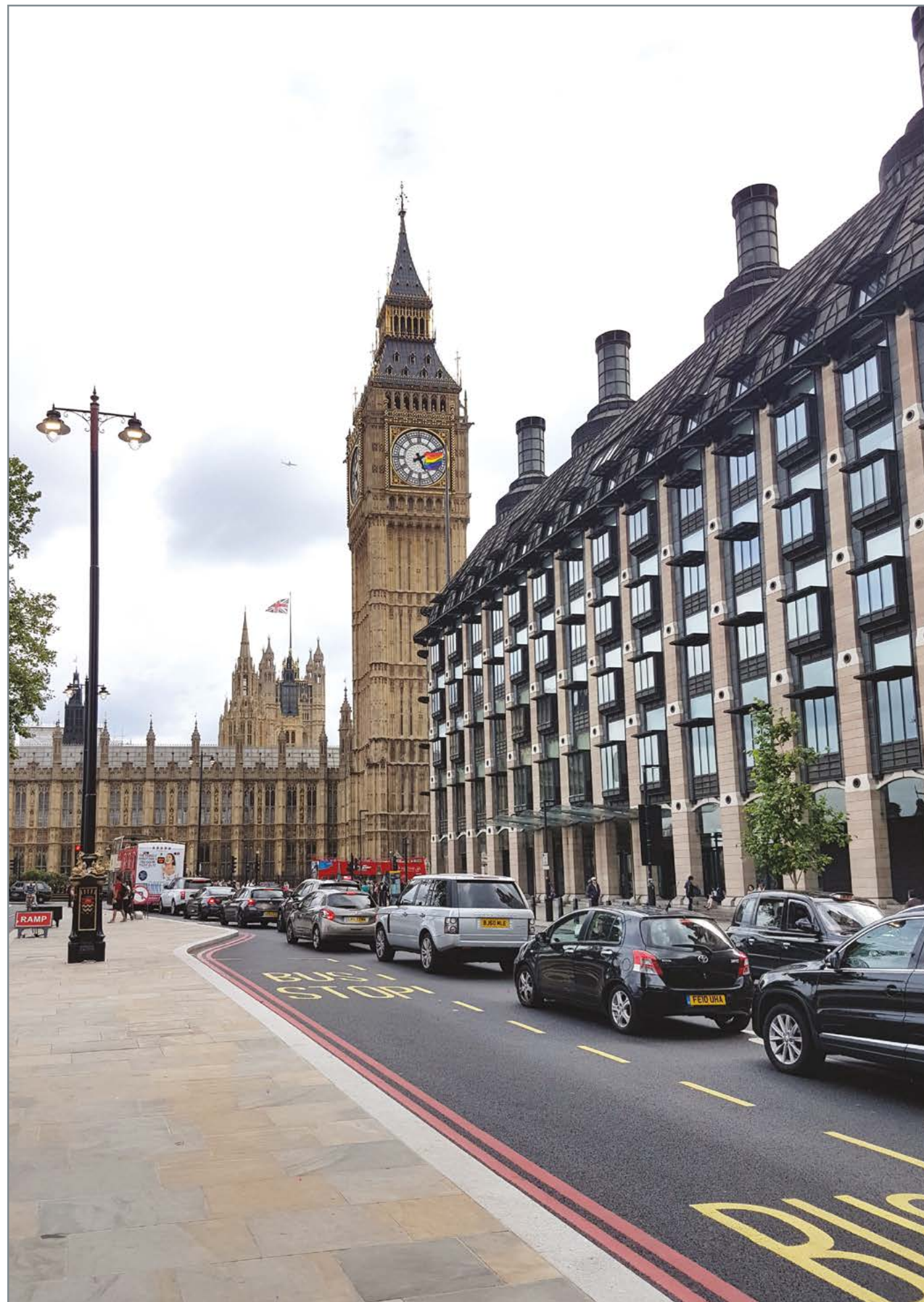
Широкоформатные тротуарные плиты без фаски с тонкими швами для удобства передвижения. Бетон. Широкий дорожный борд. Цветная сигнальная дорожная разметка. Фонарь.
