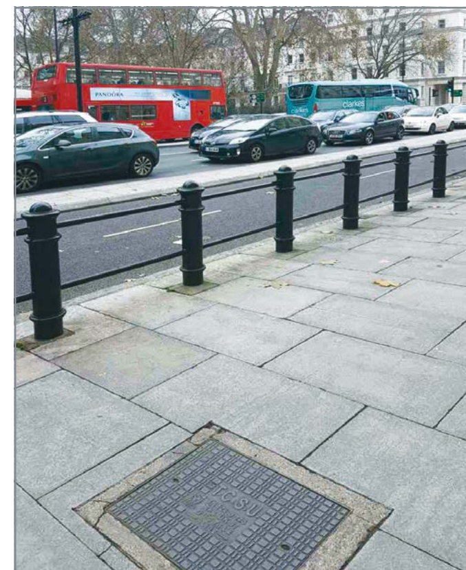
Боллард. Металл. Забетонирован в тротуар на 30см. Служит основанием металлической ограды для защиты тротуара от наезда транспорта. Дизайн классический. Крупноформатные плиты без фаски для удобного передвижения пешеходов.
