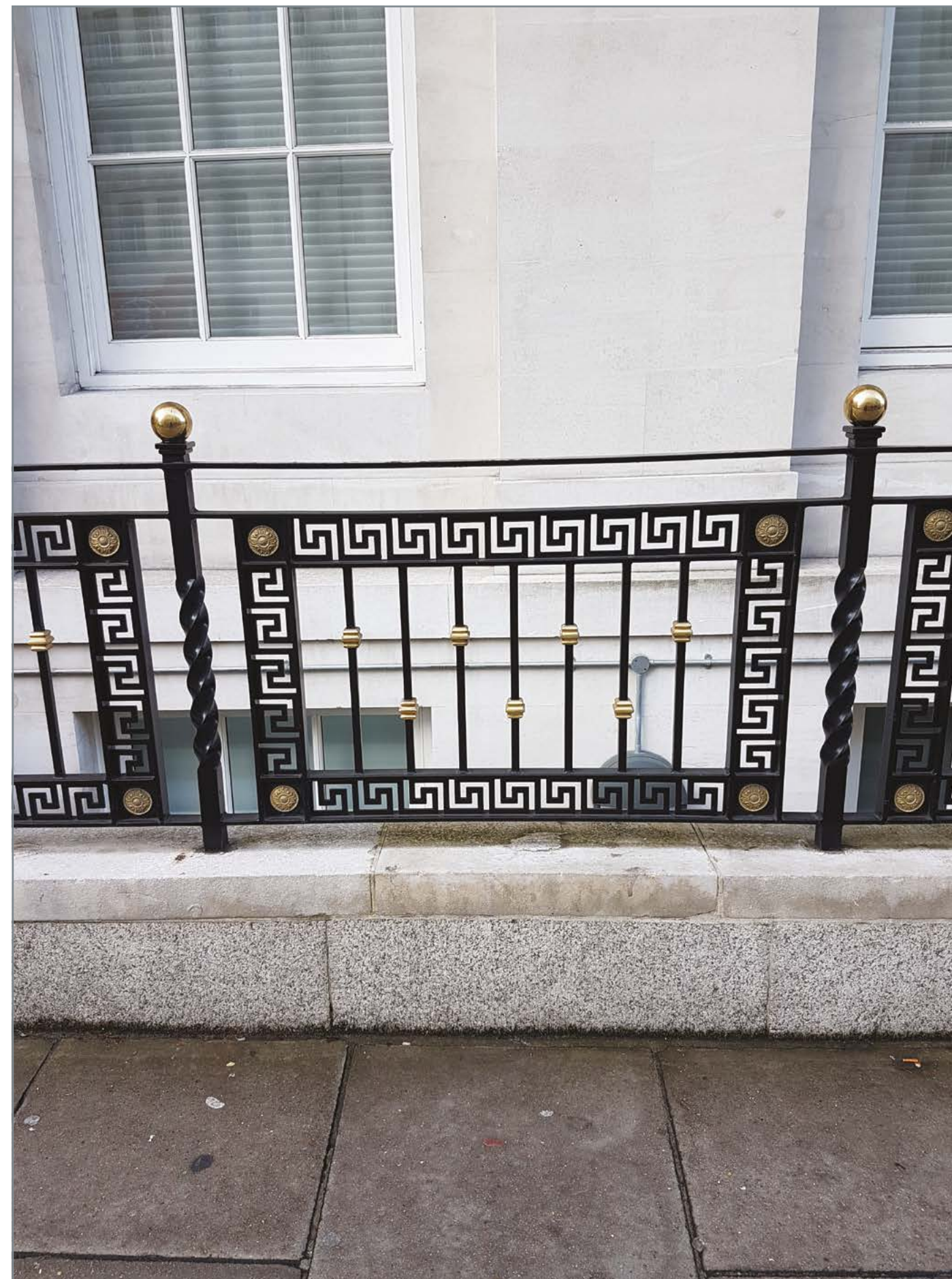
Ограда. Окрашенный металл. Защищает пешеходов от падения. Отделяет придомовую территорию от тротуара. Дизайн классический.
