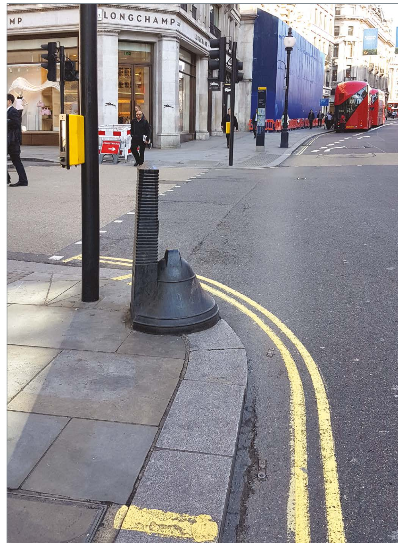
Комбинация двух боллардов. Чугун. Забетонирован в тротуар на 30см. Колокол служит для предотвращения наезда на тротуар задних колес грузовиков при повороте. Скругленный дорожный борт. Сигнальная разметка для транспорта.
