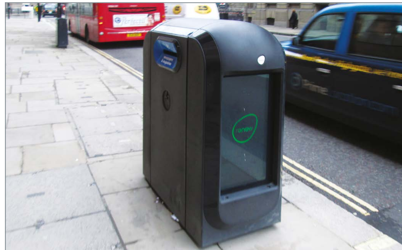
Урна. Разделение мусора для вторичной переработки. Широкоформатные тротуарные плиты без фаски с тонкими швами для удобства передвижения. Бетон.
