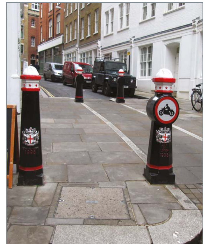
Боллард. Чугун. Забетонирован в тротуар на 30см. Защищает тротуар от наезда транспорта. Служит для установки дорожных знаков. Борт скругленный. Бетон.
