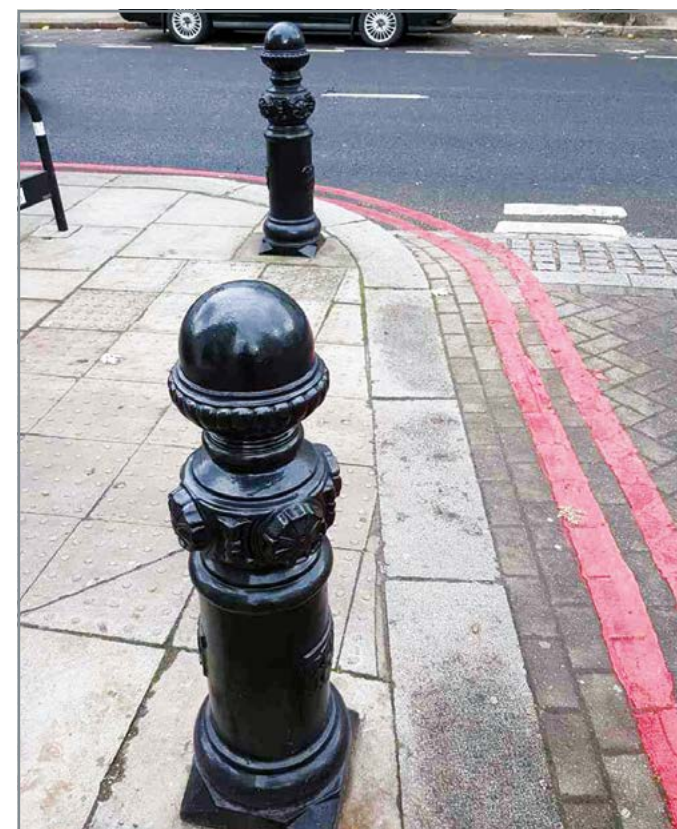
Боллард. Чугун. Забетонирован в тротуар на 30см. Защищает тротуар от наезда транспорта. Дизайн классический. Сигнальная красная линия для транспорта. Скругленный дорожный борд.
