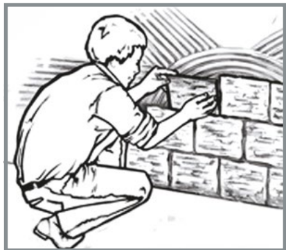
Укладання облицювального каменю на стіну
