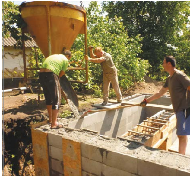
Заливання стрічкового фундаменту бетоном
