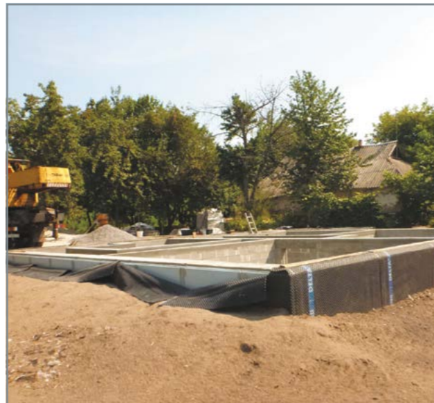
Утеплення і гідроізоляція фундаменту
