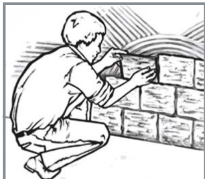
Укладання облицювального каменю на стіну
