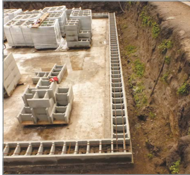
Монтаж блоків незнімної опалубки (510x400x235)
