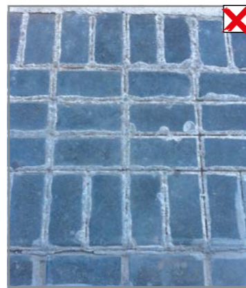
Не можна затирати шви цементно-піщаною сумішшю (гарцовкою).
