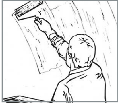
Підготовка стіни до укладання облицювального каменю.
