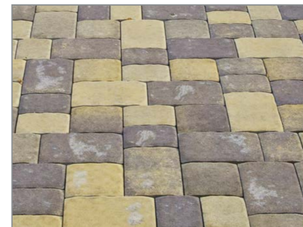
Тротуарна плитка відразу після укладання.
