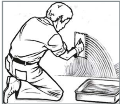
Нанесення клейової мастики на стіну
