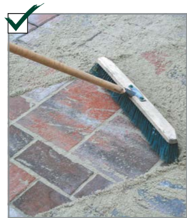
Після укладання тротуарної плитки шви затираються річковим піском .
