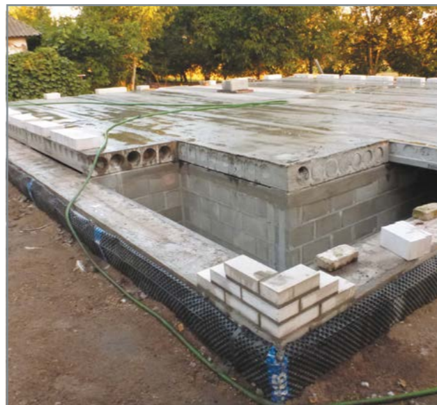
Монтаж перекриттів і стін будинку
