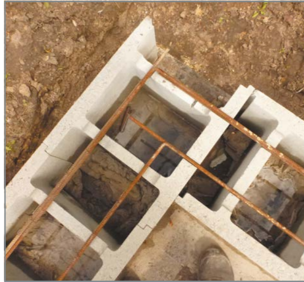
Підготовка арматурного каркасу
