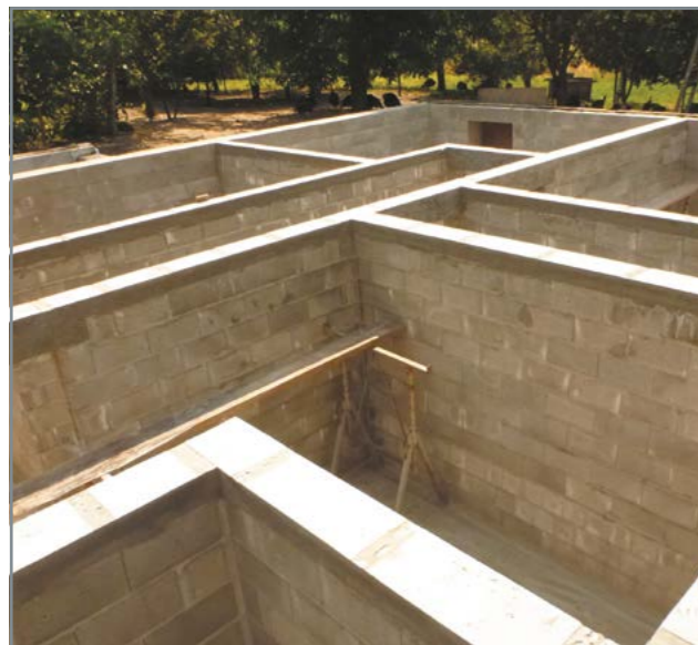
Підготовка основи під перекриття
