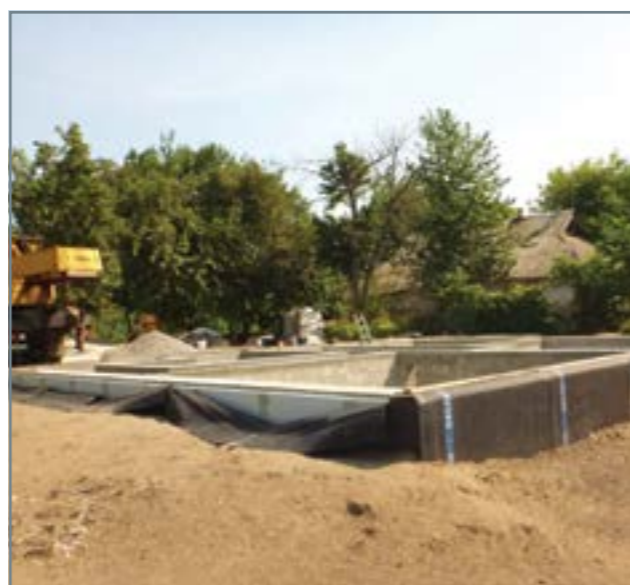
Утеплення і гідроізоляція фундаменту
