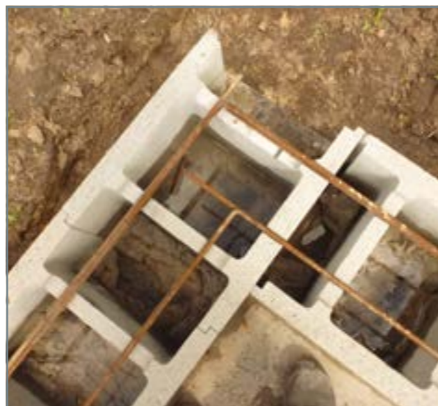
Підготовка арматурного каркасу
