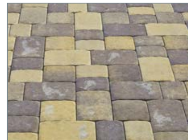
Тротуарна плитка відразу після укладання.
