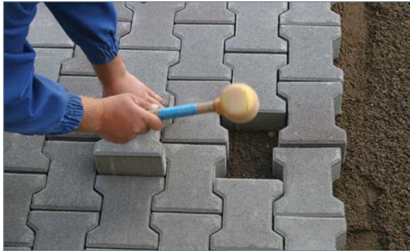
Вибір тротуарної плитки
