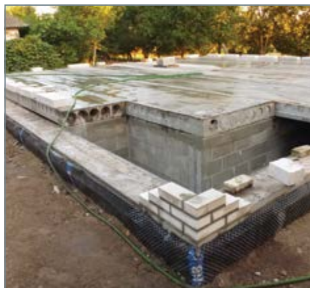
Монтаж перекриттів і стін будинку
