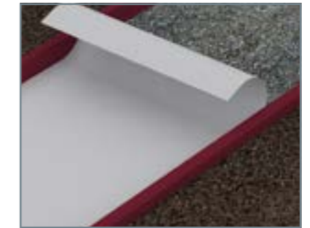
6. Укладання голкопробивного геотекстилю (щільність 120г / м2).
