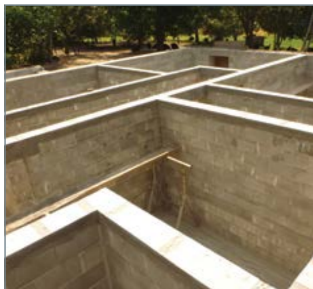
Підготовка основи під перекриття
