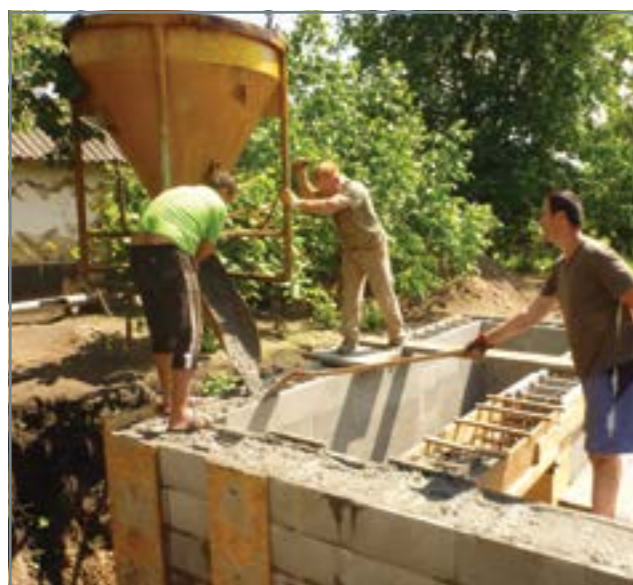
Заливання стрічкового фундаменту бетоном
