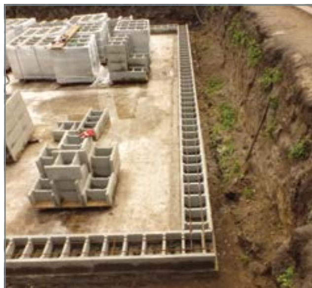
Монтаж блоків незнімної опалубки (510x400x235)
