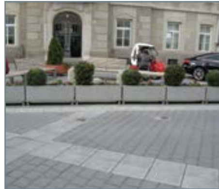
Приклад мощення з використанням елементів 200x200x100 мм
