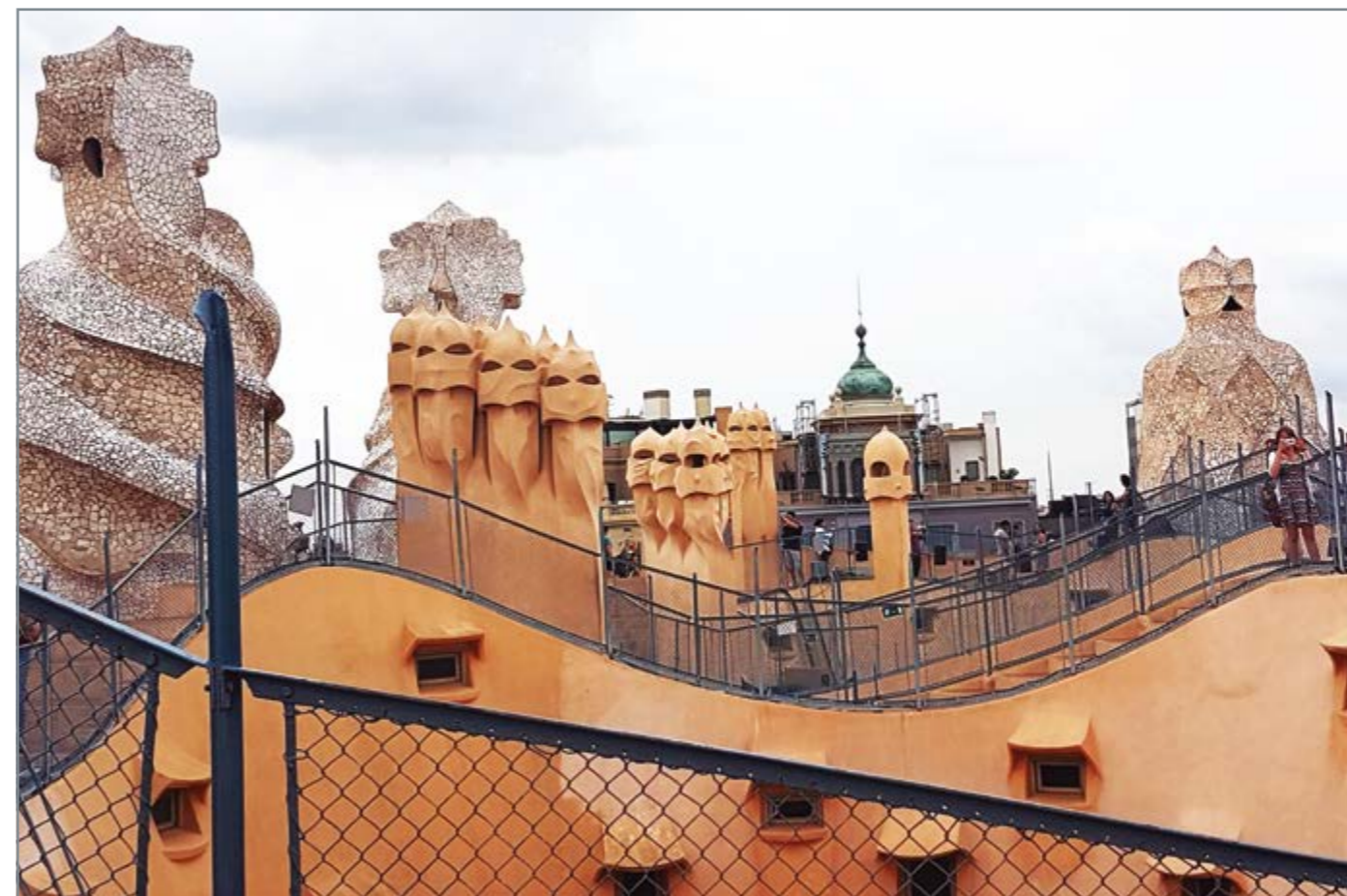
Дом «Каса Мила». Крыша с вентиляционными трубами и дымоходами. Архитектор А. Гауди.
