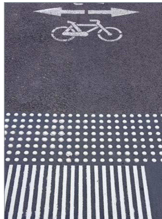
Тактильная разметка на пешеходном переходе.
