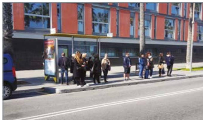
Автобусная остановка с освещением. Приподнятая бетонная посадочная платформа. Материалы: металл, пластик, стекло.
