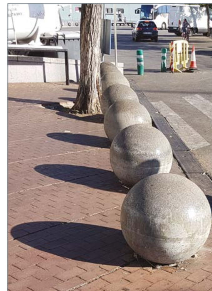
Болларды в виде шаров. Материал: бетон.
