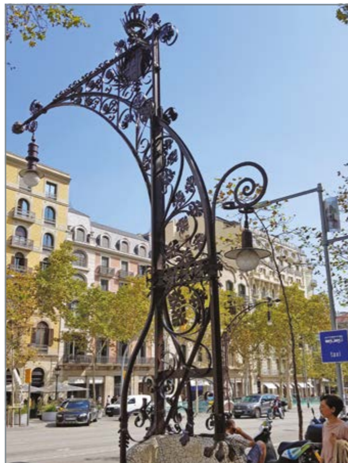
Фонарь двусторонний. Освещает проезжую часть с одной стороны и тротуар с другой.
