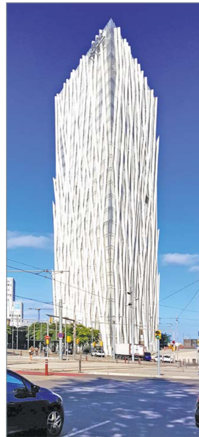
Diagonal Zero Zero. Высота: 110 метров. Архитектор: Estudi Massip-Bosch Arquitectes SL.
