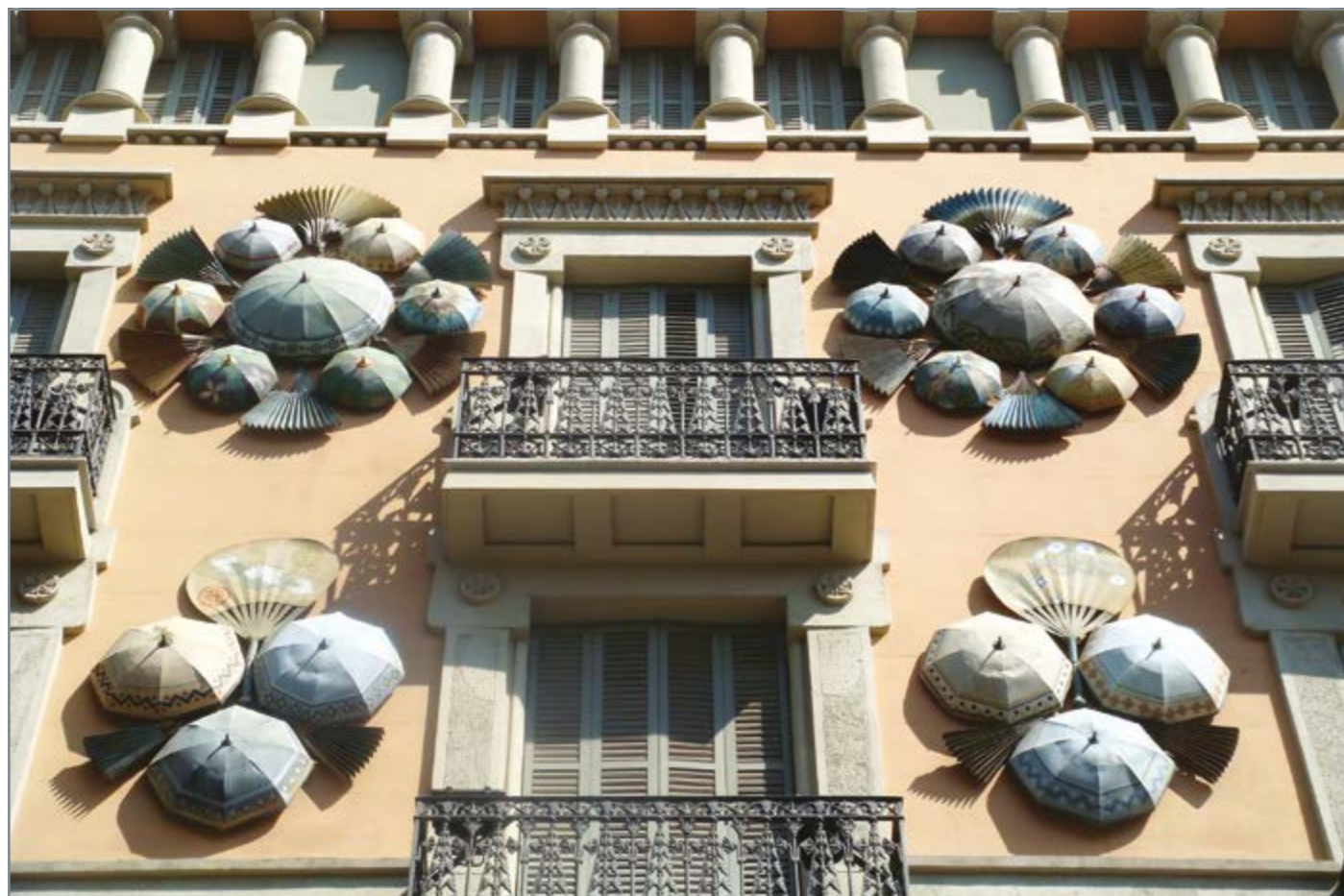
Дом с зонтиками 1858 г. На первом этаже был когда-то магазин зонтов. И реклама, и оригинальный, запоминающийся фасад.
