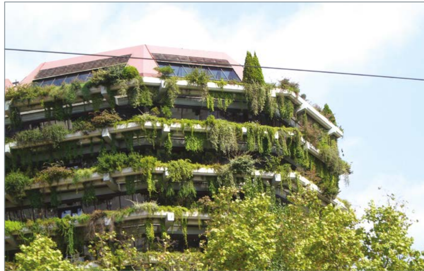
Фасад с озеленением. Насаждения хорошо защищают стены здания от нагрева в жаркую погоду.
