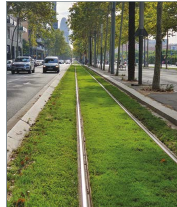
Трамвайные пути оформлены газоном.
