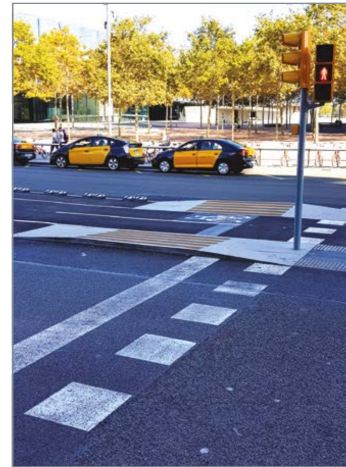
Разметка на пешеходном переходе. Велодорожка ограждена специальными разделителями.
