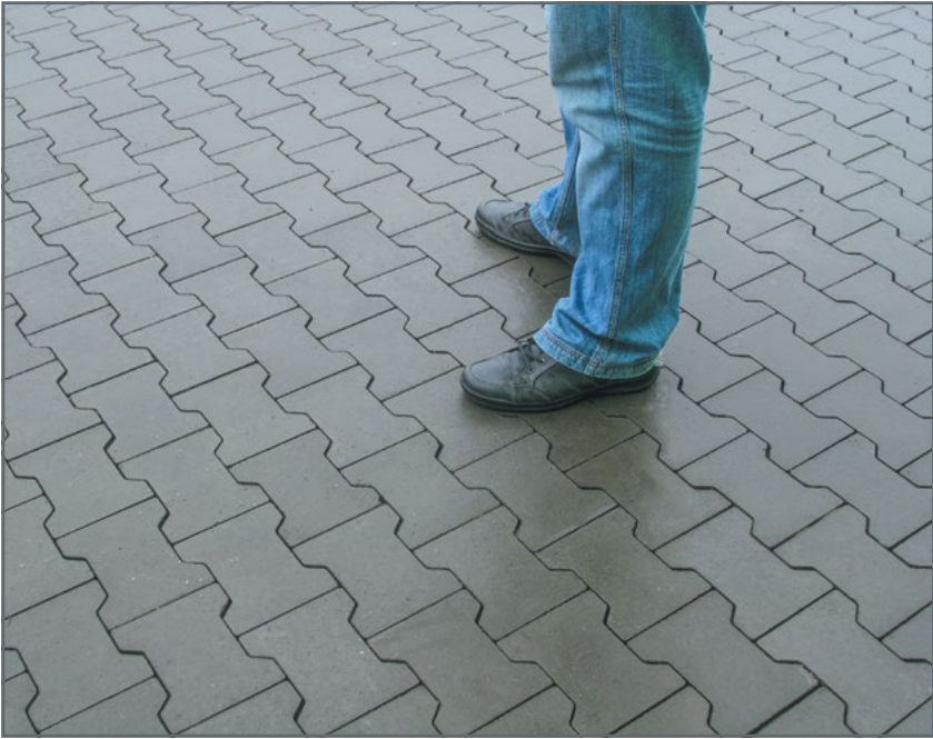
Подвійне Т без фаски (сірий) після дощу
