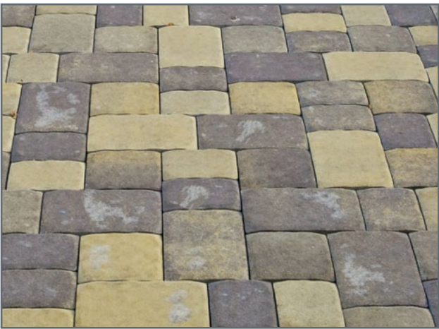
Тротуарна плитка відразу після укладання.
