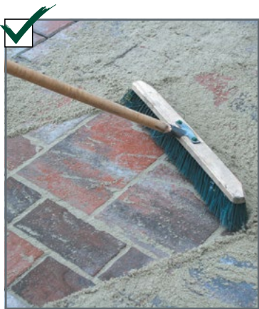
Після укладання тротуарної плитки шви затираються річковим піском.
