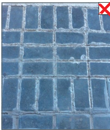
Не можна затирати шви цементно-піщаною сумішшю (гарцовкою).
