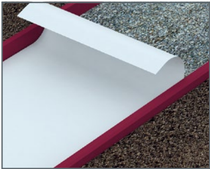
6. Укладання голкопробивного геотекстилю (щільність 120г / м2).
