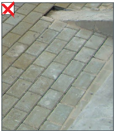
Не допускати попадання цементу або розчину на покриття з тротуарної плитки.
