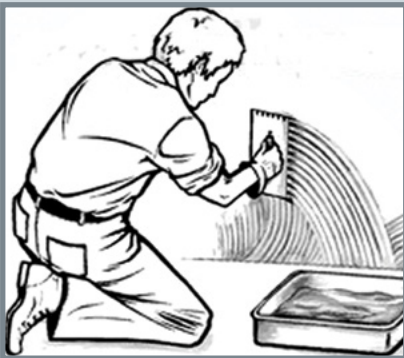
Нанесення клейової мастики на стіну
