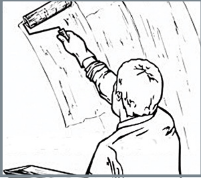
Підготовка стіни до укладання облицювального каменю.
